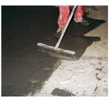
Материал PCI Repahaft посредством щётки наносится на основание. Непосредственно после этого свежий раствор для пола наносится на свежий адгезионный слой
