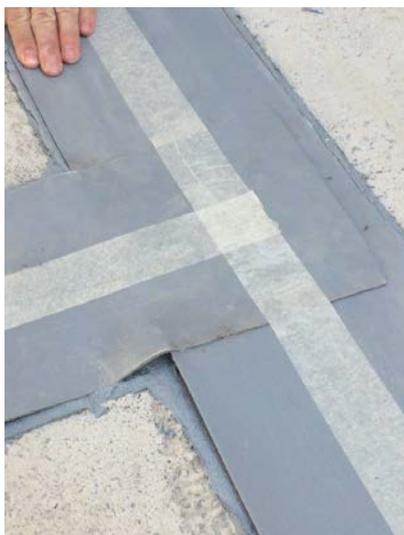
Рисунок 4 – укладка ленты и разметка зоны нанесения 2-го слоя клея
