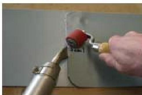
4.4.10. Обеспечивать непрерывное постоянное движение сварочного аппарата и ролика
