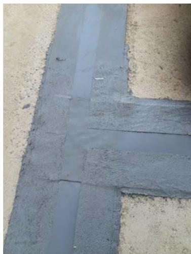
Рисунок 6 – окончательный вид гидроизоляционной системы
