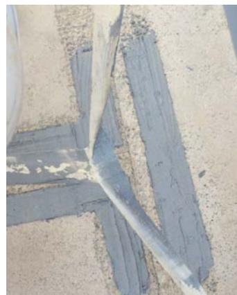
Рисунок 3 – нанесение первого слоя клея
