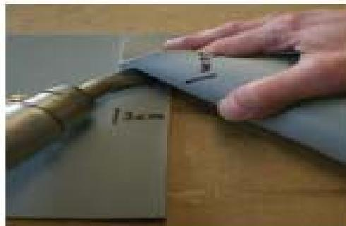
4.4.8. Для сварки использовать ручной сварочный аппарат для ПВХ мембран. Начинать с края
