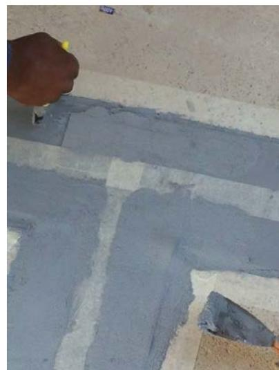
Рисунок 5 – нанесение первого слоя клея
