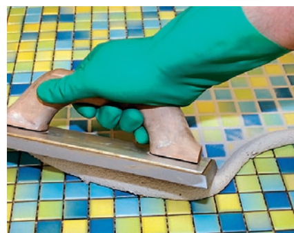
Химически стойкая и водонепроницаемая затирка мозаичных покрытий с помощью PCI Durapox NT и PCI Durapox NT plus.
