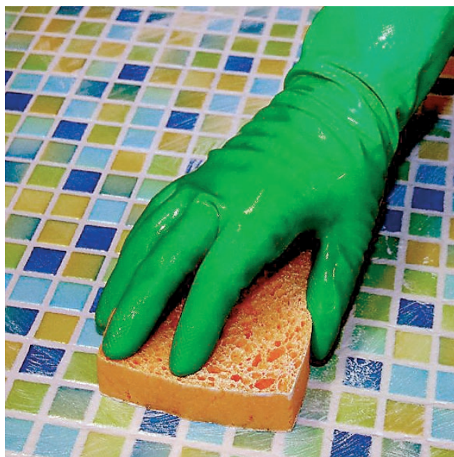
Мытье затертого покрытия мягкой эпоксидной губкой PCI
