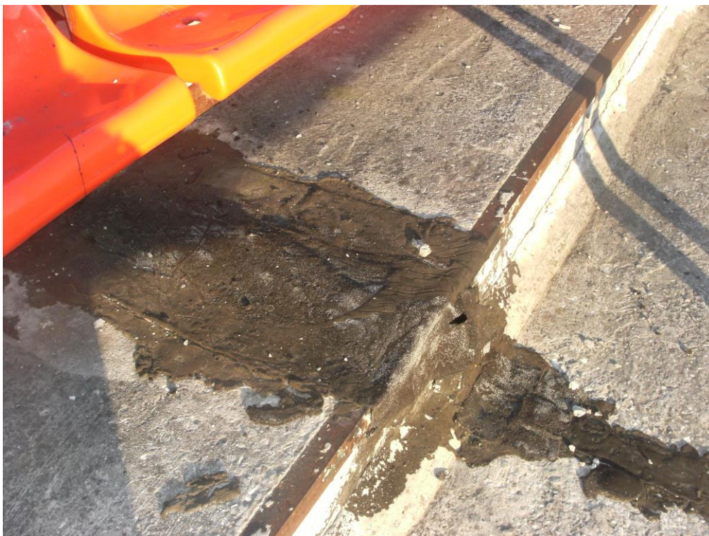
Шов сопряжения конструкций трибун.
