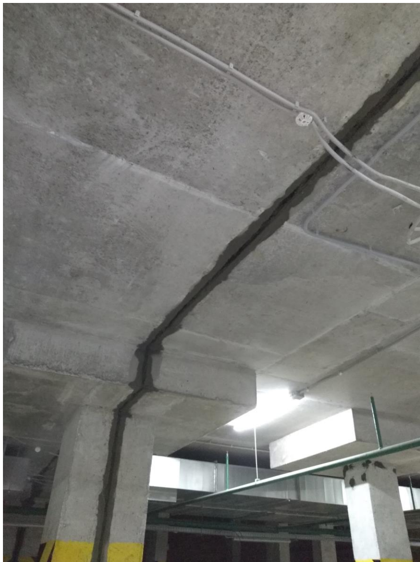
Деформационный шов подземного паркинга.
