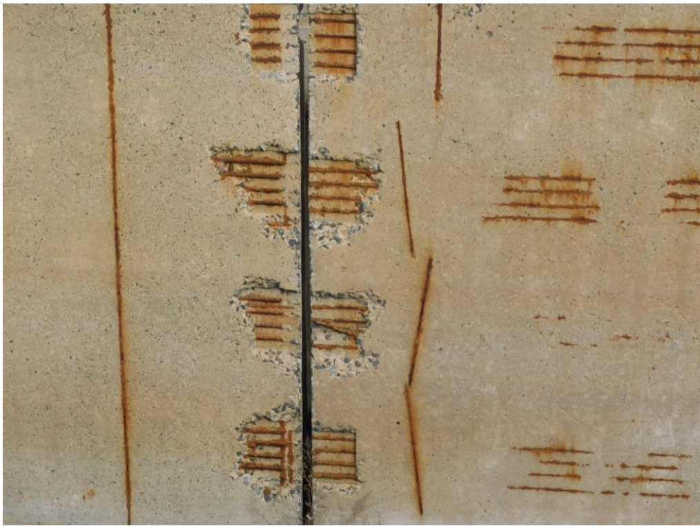
Шов сопряжений стеновых панелей аэротенков очистных сооружений.
