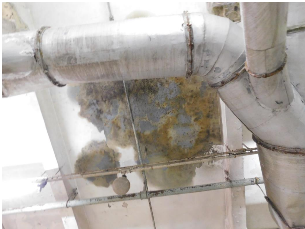
Карбонизация бетона, загрязнение маслом полки монолитного перекрытия.
