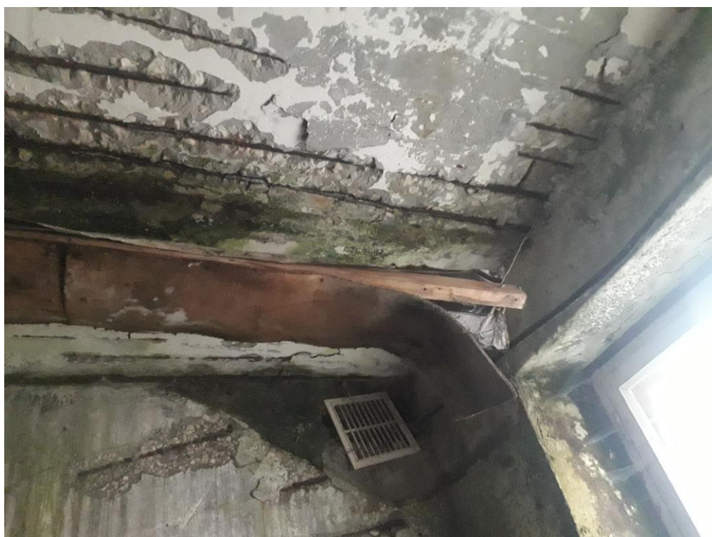
Карбонизация бетона, загрязнение маслом полки монолитного перекрытия.
