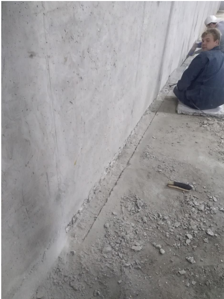
Ремонт шва сопряжения (сухой шов) фундамент-стена.
