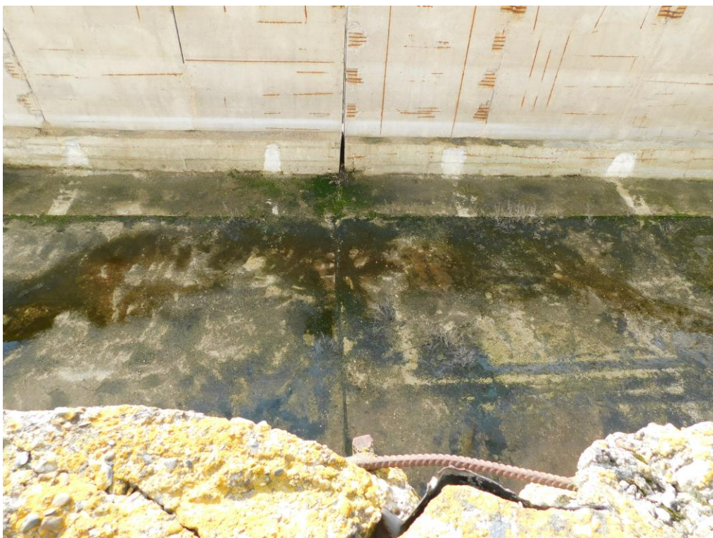
Деформационный шов аэротенков очистных сооружений.
